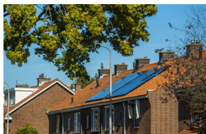
Panneaux solaires sur les toits des logements résidentiels aux Pays-Bas. © Lorado/Gettyimages
