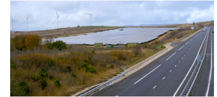
Parc photovoltaïque en bordure de l'A75, La Cavalerie (12). L'impact visuel d'une centrale est important aux abords immédiats de la voirie. Le choix de châssis légers améliore les perceptions à moyenne distance. © Étienne Louyriac
