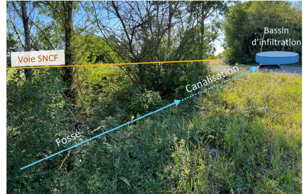
Figure 23 : Fossé d'exutoire de la noue en direction du bassin d'infiltration
