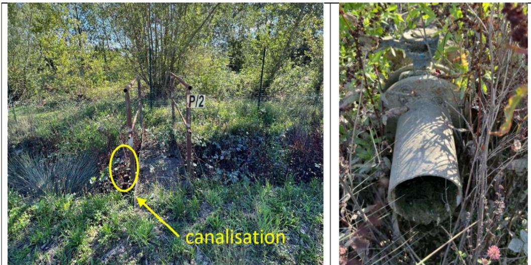
Figure 22 : Canalisation d'évacuation de la noue avec dépôts organiques
