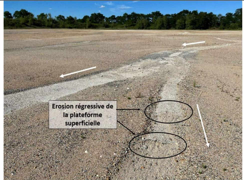
Erosion régressive de la plateforme superficielle
