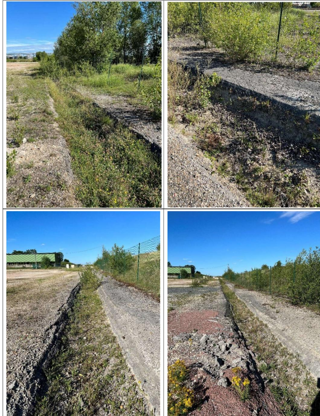
Par endroit, la couche d'enrobé a été volontairement saignée pour permettre aux eaux de pluie de s'écouler plus facilement et limiter le phénomène de flaques vu auparavant. Ces saignées laissent apparaître les sols, à priori d'origine, riche en silex.
