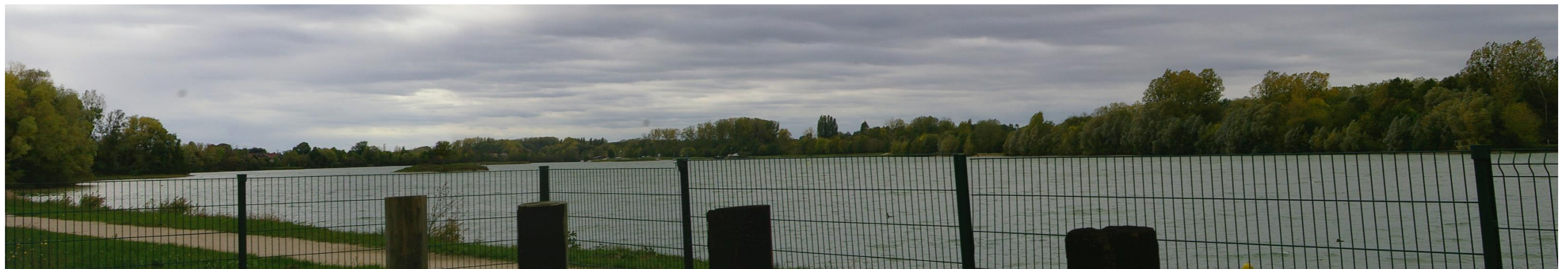
Figure 8 : Un des nombreux plans d'eau du territoire d'étude : la base nautique des étangs du rive du Loing
