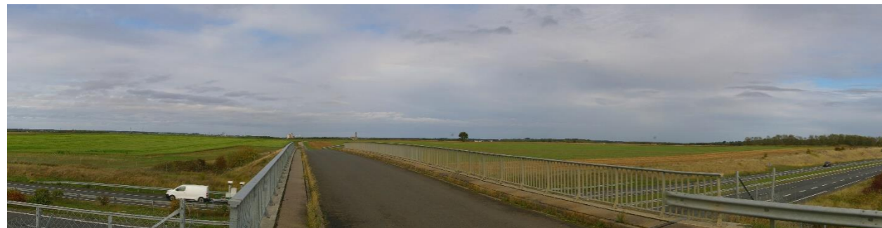
Figure 18 : Depuis un pont de l'A77, les vues sont lointaines sur une plaine cultivée
