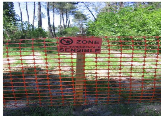
Exemples de clôture en filet de chantier en plastique pour mise en exclos et panneau de signalisation
