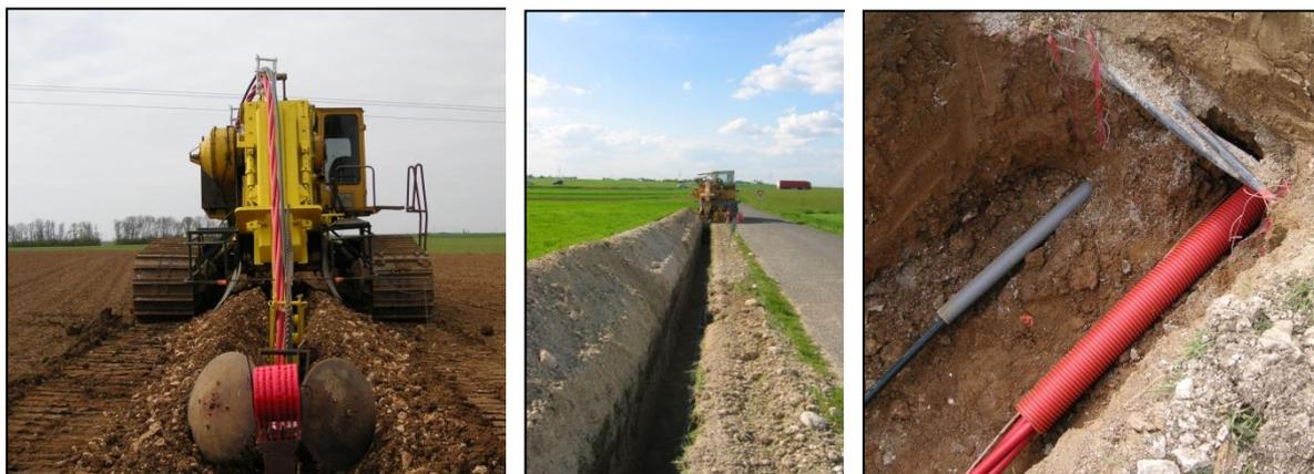
Figure 17 : Photos illustrant l'installation du câblage interne – Source : NORDEX
