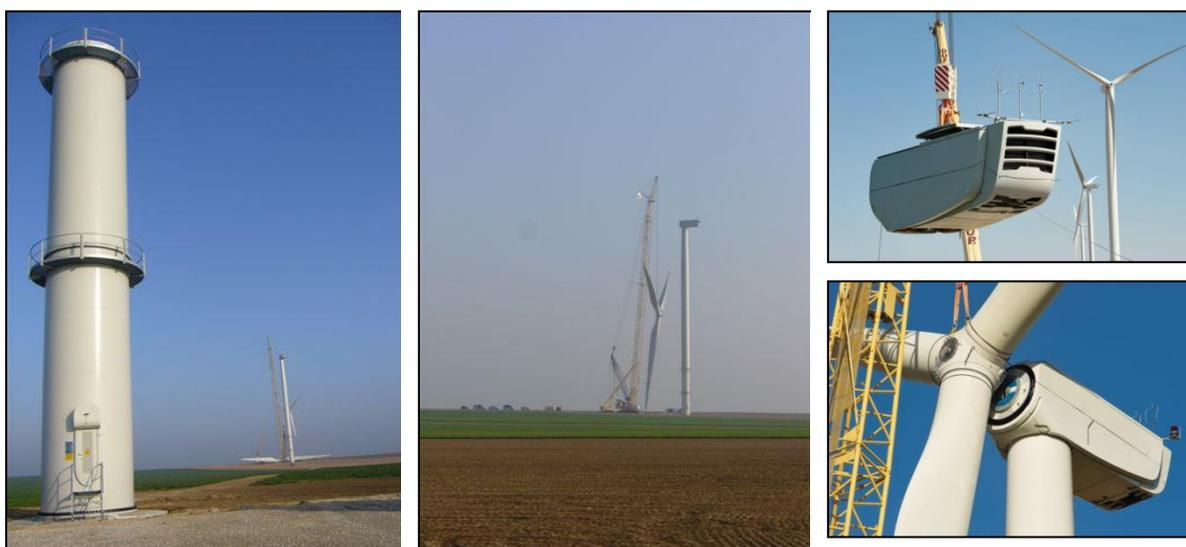
Figure 16 : Photos illustrant le montage d'une éolienne – Source : NORDEX
