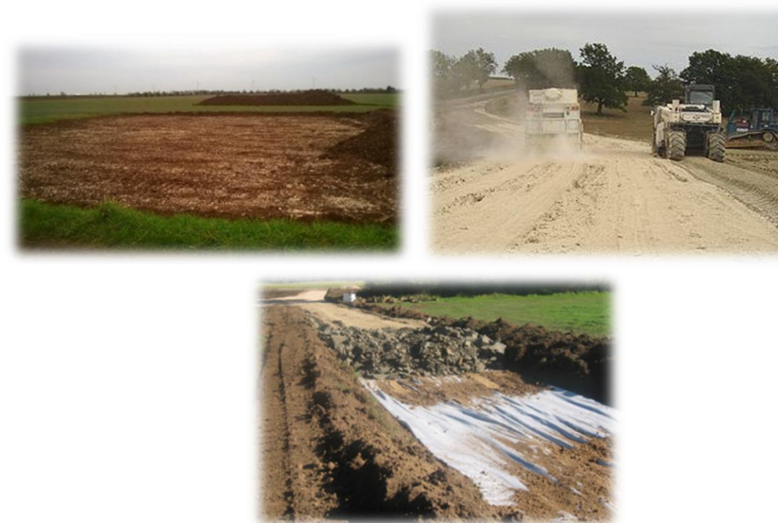
Figure 13 : Étape de création des pistes et plateformes (Source : ENERCON)
