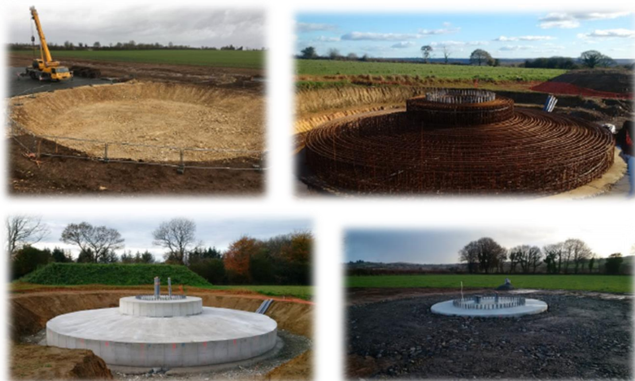
Figure 14 : Mise en œuvre d'une fondation (Source : ENERCON)
