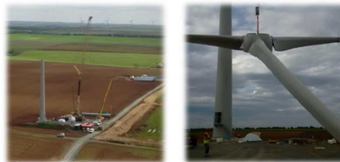
Figure 15 : Montage du mât (à droite) et levage du rotor (à gauche) (Source : ENERCON)
