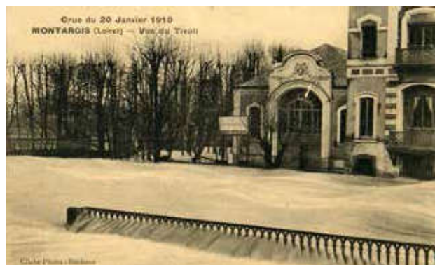
Source : Fonds des Amis du Vieux Montargis (3Z) Archives municipales de Montargis
